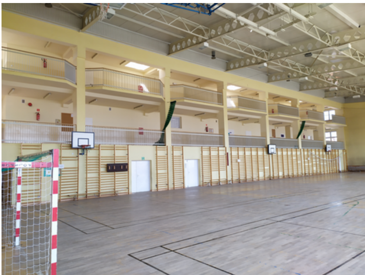
Fot. 7, 8 i 9 Balustrady.
