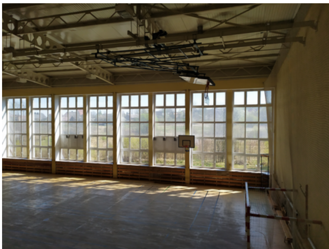
Fot. 1 i 2. Okna na sali gimnastycznej.
