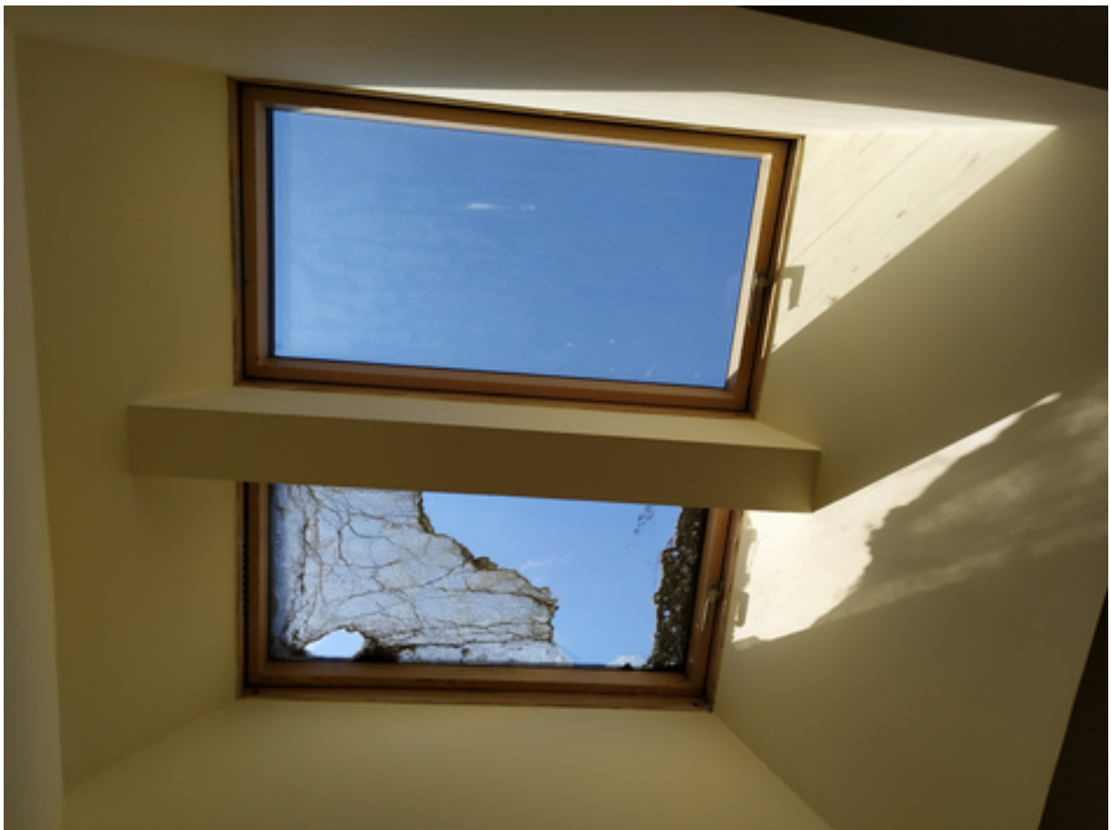
Fot. 3 i 4 Okna połaciowe.
