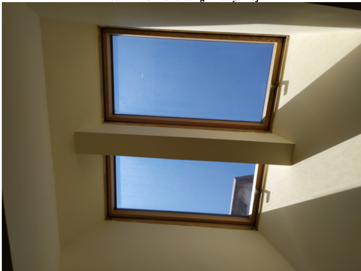
Fot. 1 i 2. Okna na sali gimnastycznej.
