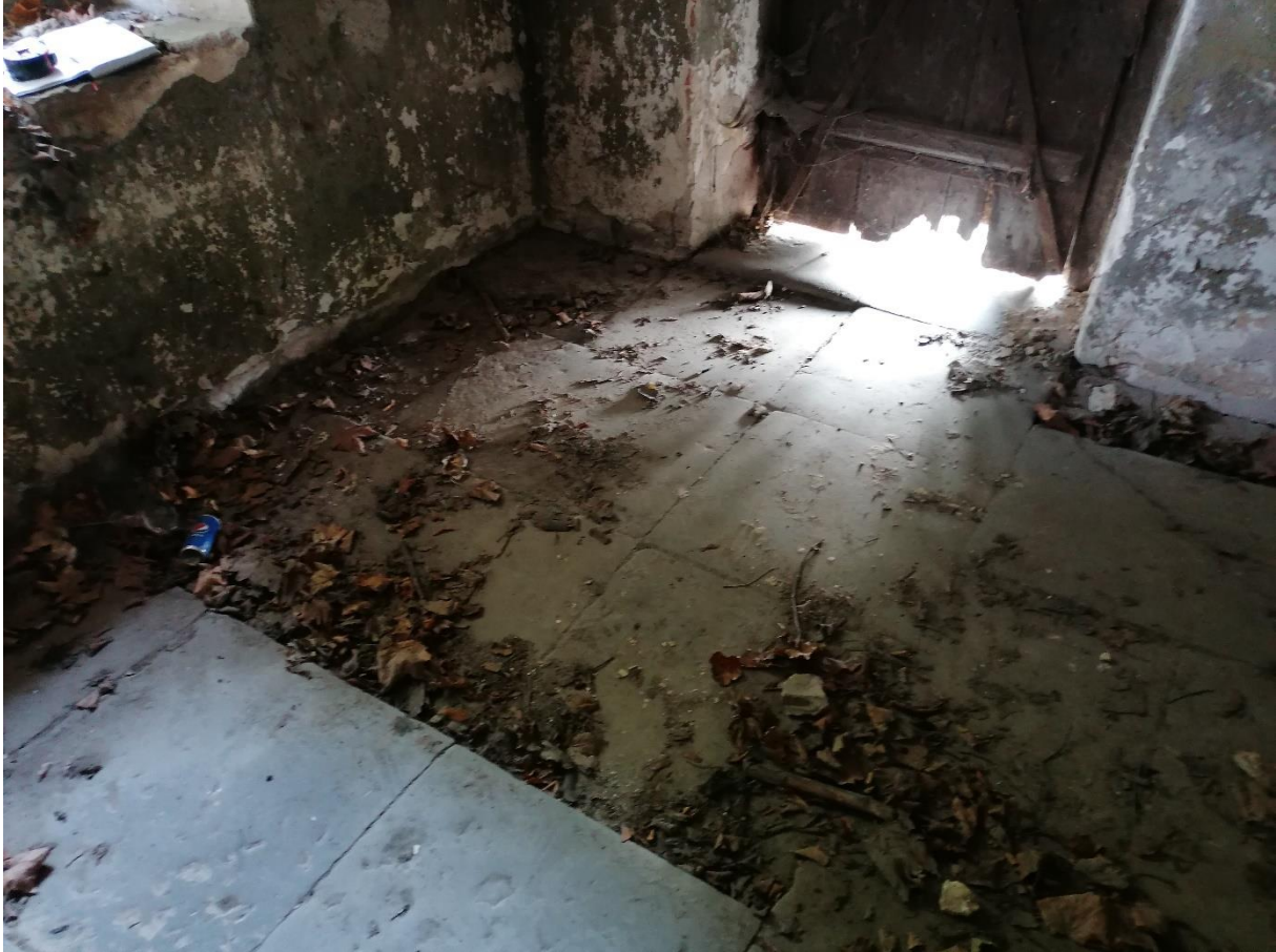
Zdj.36 Posadzka w zakrystii
