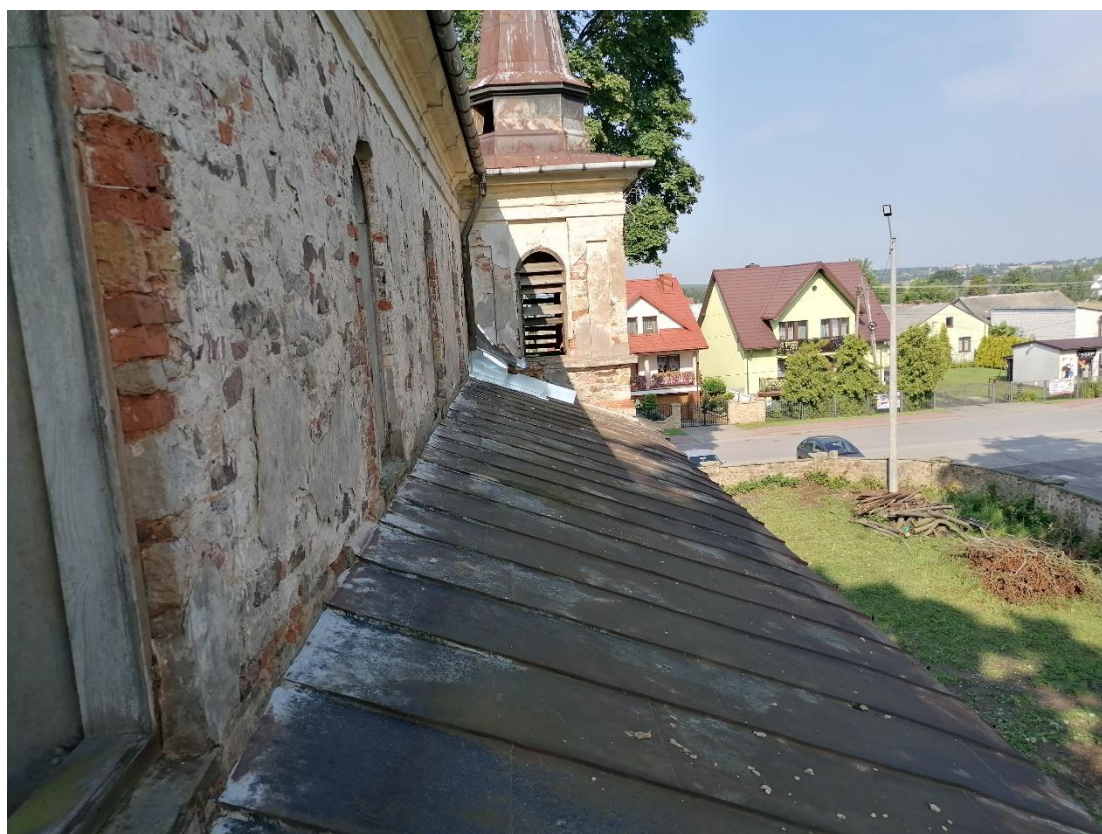
Zdj.26 Dach nad nawą północną. Widoczna tymczasowa obróbka styku z murem
