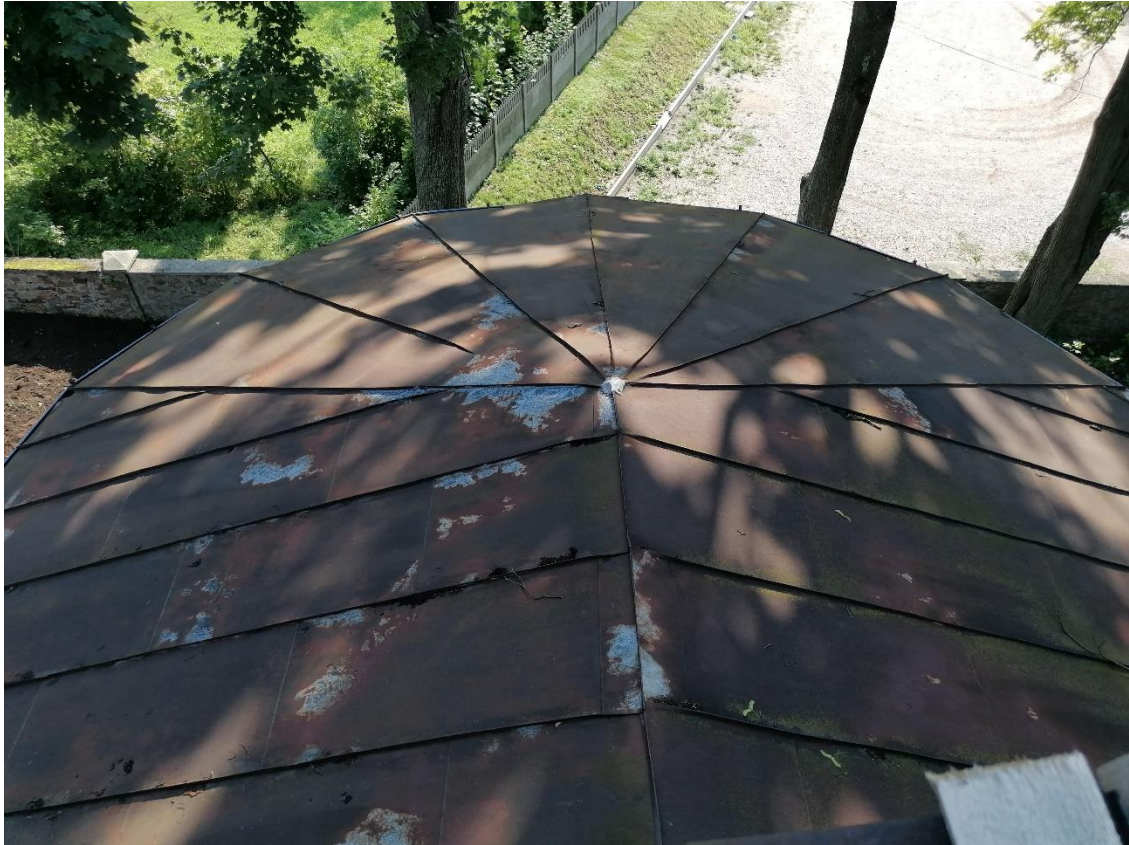
Zdj.23 Dach prezbiterium
