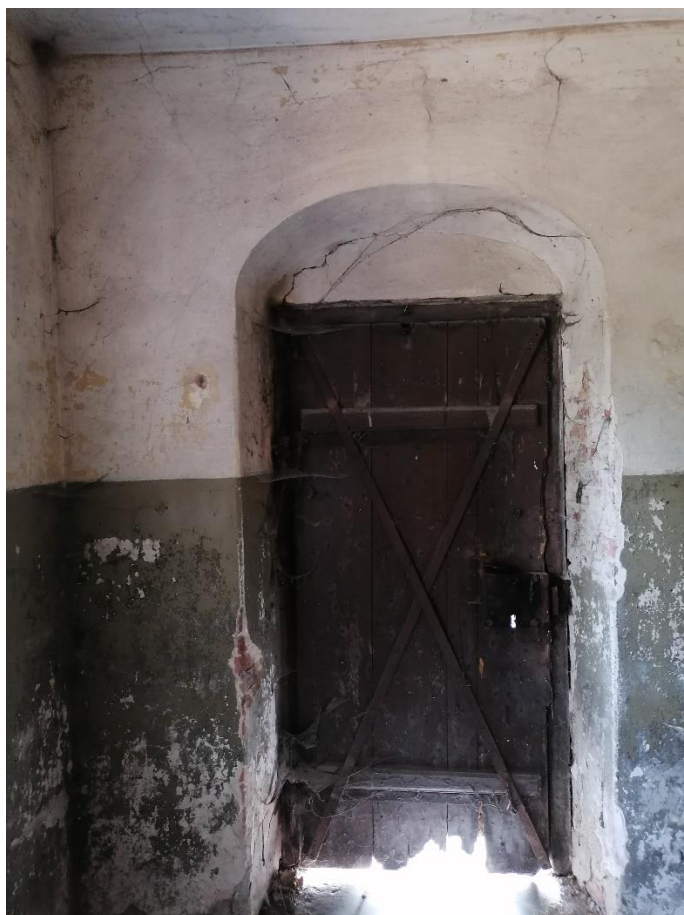
Zdj.7 Drzwi zewnętrzne zakrystii – sklepienie łukowe eliptyczne
