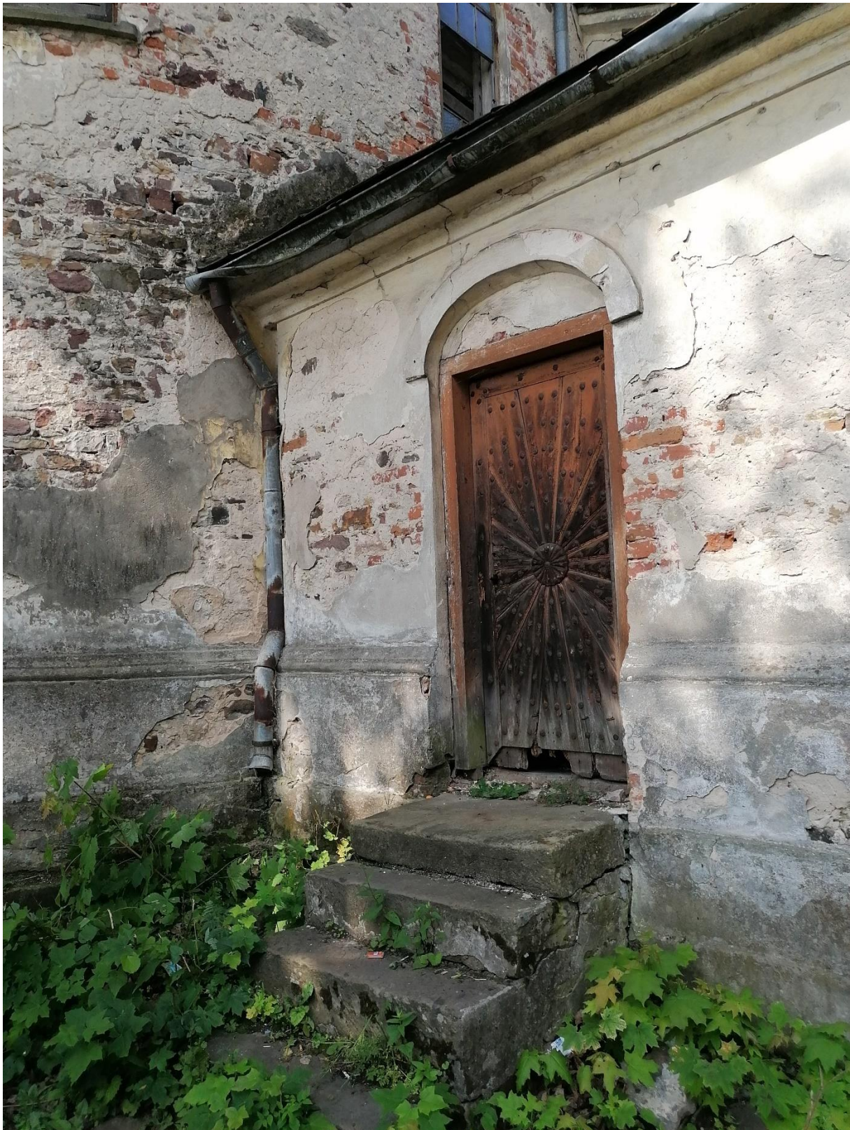
Zdj.42 Schody zakrystii
