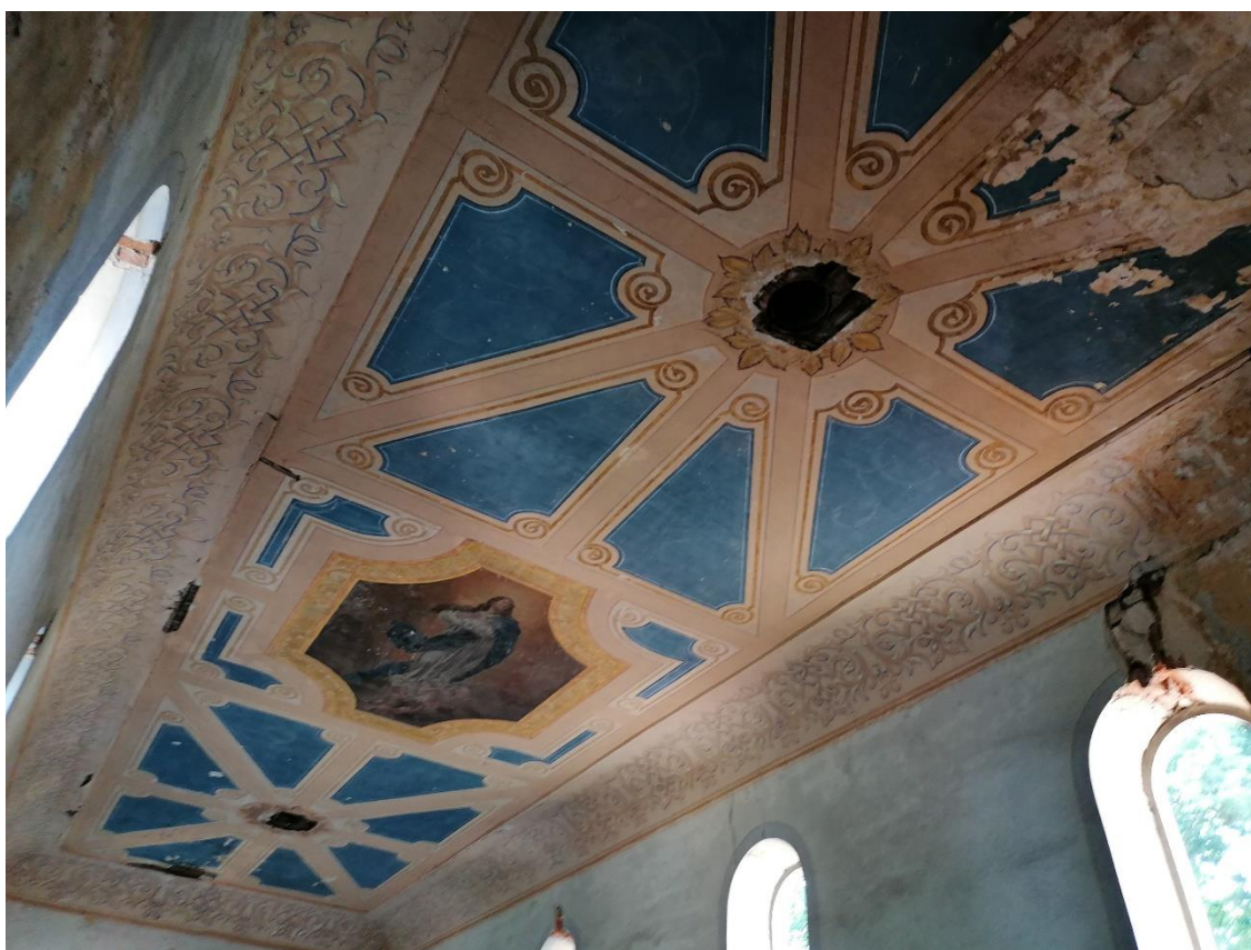
Zdj.15 Sufit nawy głównej
