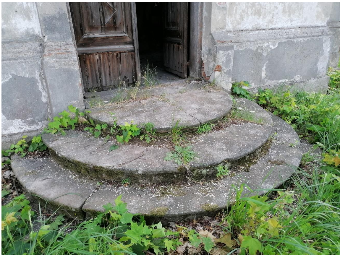
Zdj.41 Schody wejścia głównego
