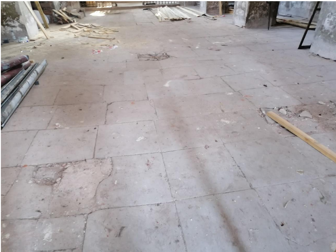
Zdj.39 Posadzka w nawie głównej
