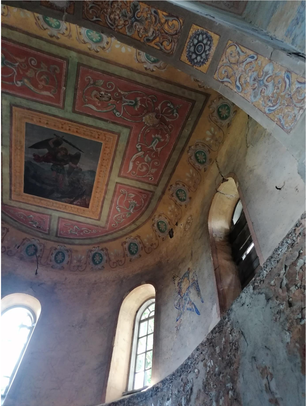
Zdj.17 Sufit i ściany prezbiterium
