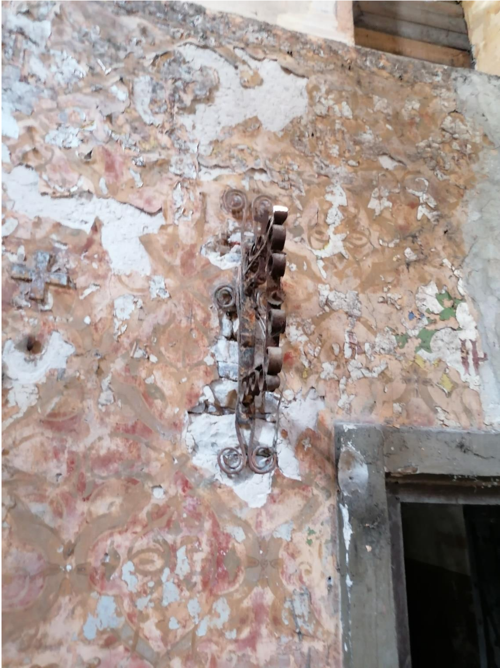
Zdj.16 Ściana przy wejściu do zakrystii
