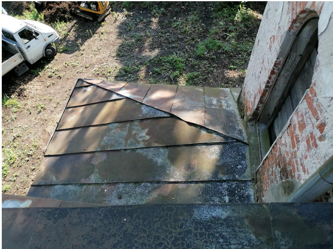
Zdj.24 Dach nad zakrystią
