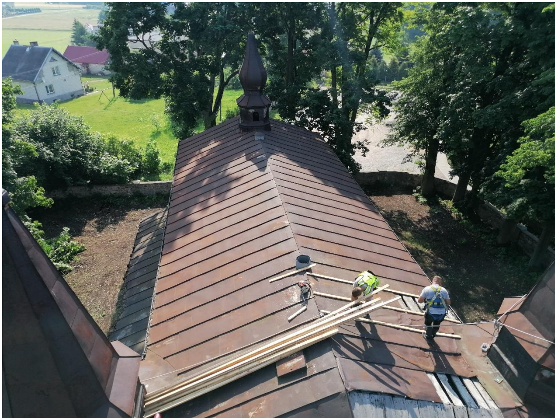
Zdj.21 Dach w trakcie prac zabezpieczających
