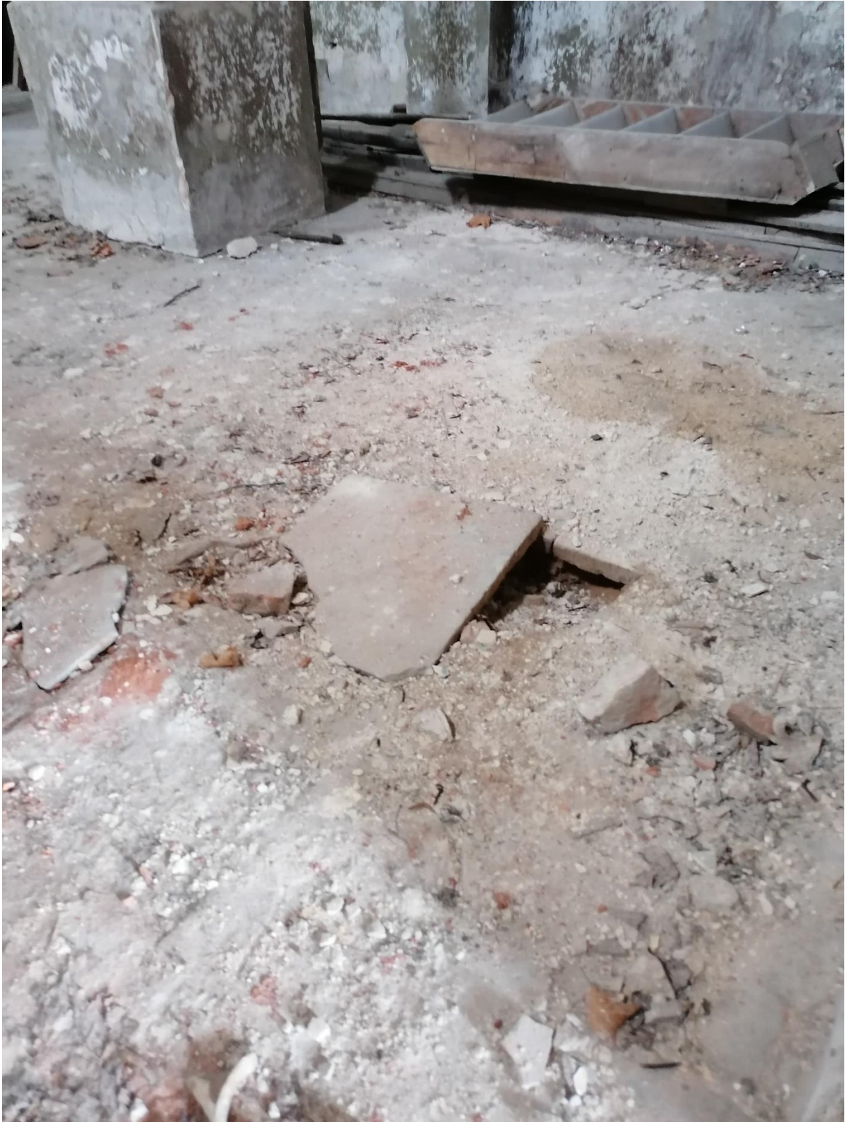
Zdj.37 Posadzka w nawie głównej
