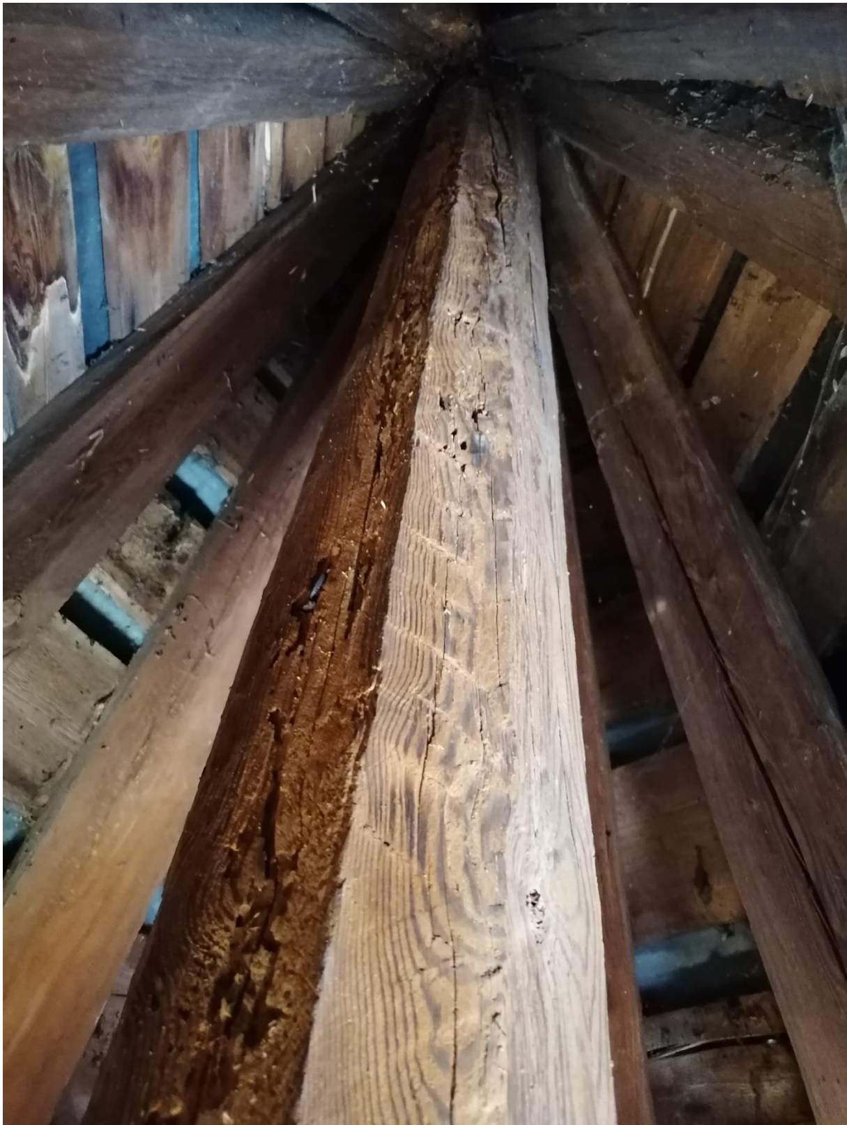
Zdj.29 Wieża frontowa. Słup, drążony przez owady
