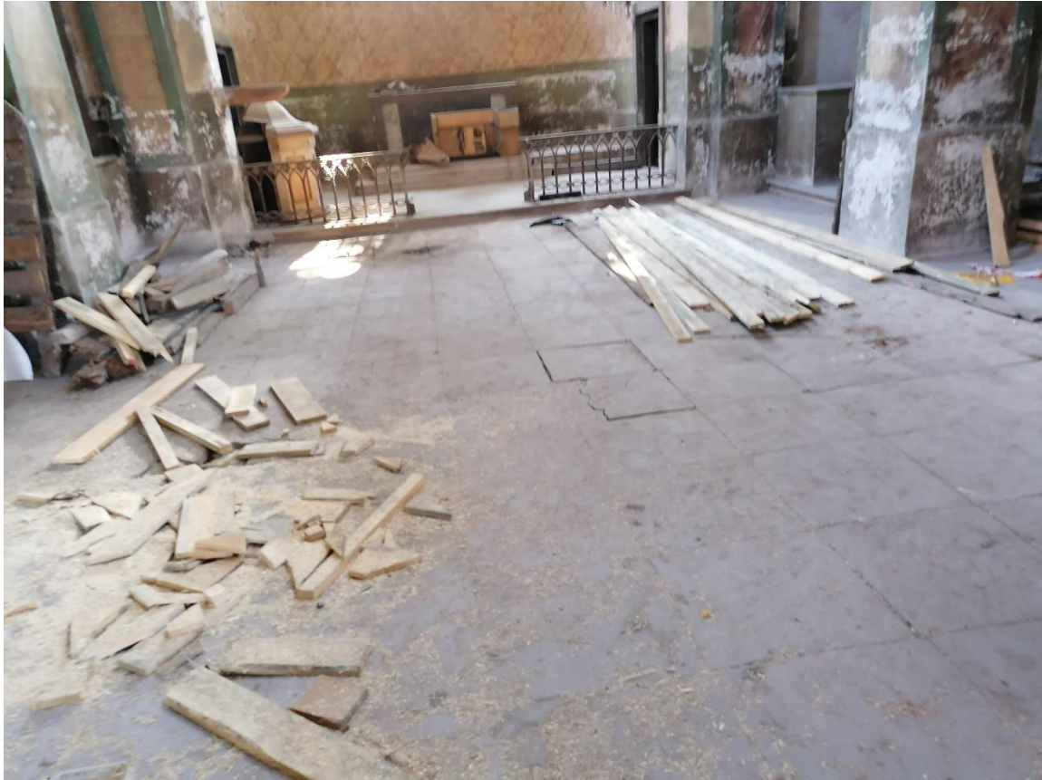
Zdj.40 Posadzka w nawie głównej
